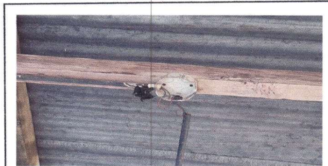
Foto 6. Reparación del cableado eléctrico
